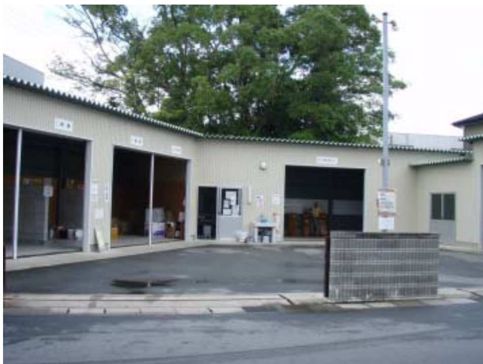
写真1 伊勢中央資源回収ステーションの外観
